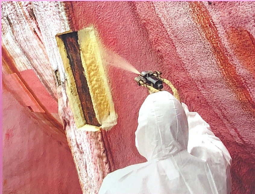
Stark beschädigte Bereiche wurden mit einem Brotmesser ausgeschnitten und mit PU-Schaum neu aufgefüllt.
