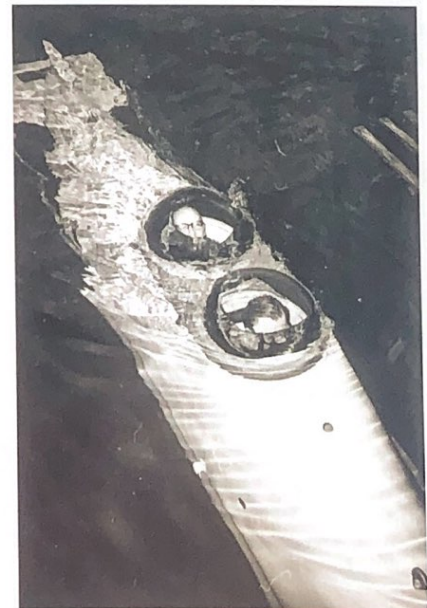
Testfahrt des Sport-U-Boots Tigerhai, an dessen Entwicklung Christian Boës mitarbeitete, in einer Schlepprinne der VWS (um 1963). Quelle: Fachgebiet Dynamik Maritimer Systeme der TU Berlin / Bestände der ehemaligen VWS
